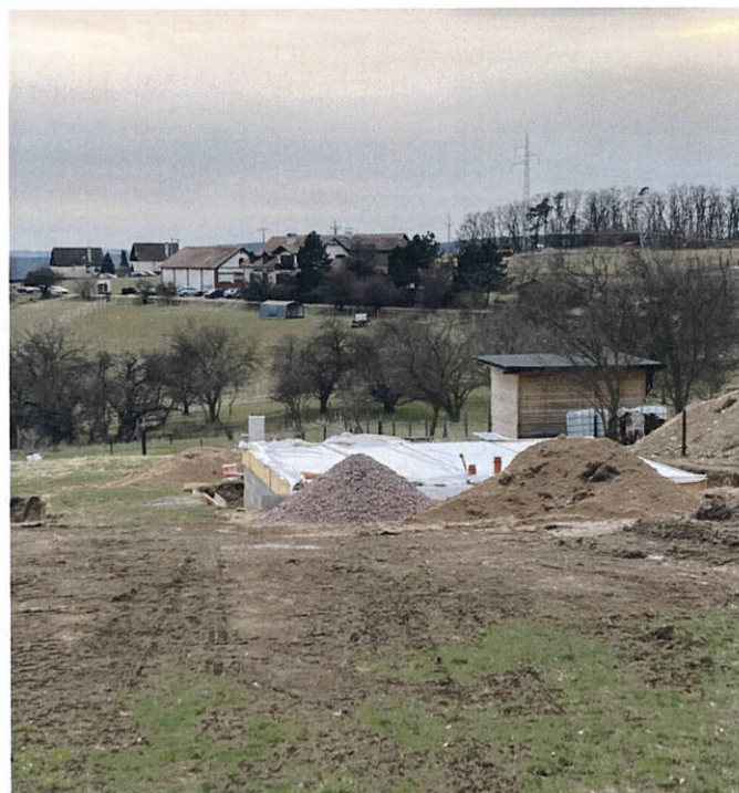
Černá stavba nad Ořešínem - pohled od lesa směrem ze směru na Utěchov směrem k ranči. Stav 12. 3. 2023.
